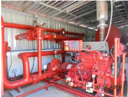
ภาพที่ 2.1-24 ระบบปั๊มดับเพลิง
