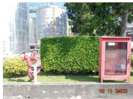
ภาพที่ 2.1-34 ระบบดับเพลิงบริเวณคันคอนกรีตรอบ ถังเก็บฟอร์มัลดีไฮด์
