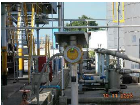
ภาพที่ 2.1-31 ระบบตรวจจับการรั่วไหลของฟอร์มัลดีไฮด์ (Fixed Gas Detector)
