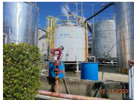
ภาพที่ 2.1-32 Fixed Foam Monitor บริเวณถังเก็บฟอร์มัลดีไฮด์
