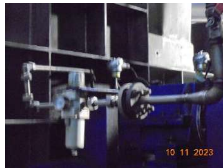
ภาพที่ 2.1-30 การติดตั้งกล้องวงจรปิดและอุปกรณ์วัดความดัน ภายในห้องเครื่องเป่าอากาศ (Blower Room)
