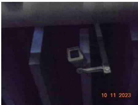
ภาพที่ 2.1-30 การติดตั้งกล้องวงจรปิดและอุปกรณ์วัดความดัน ภายในห้องเครื่องเป่าอากาศ (Blower Room)
